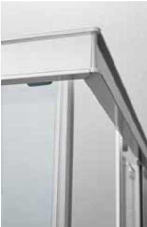
_Il giunto a 45° è il punto d'incontro dei profili perimetrali/ The 45° joint is the point where the perimeter profiles meet.
